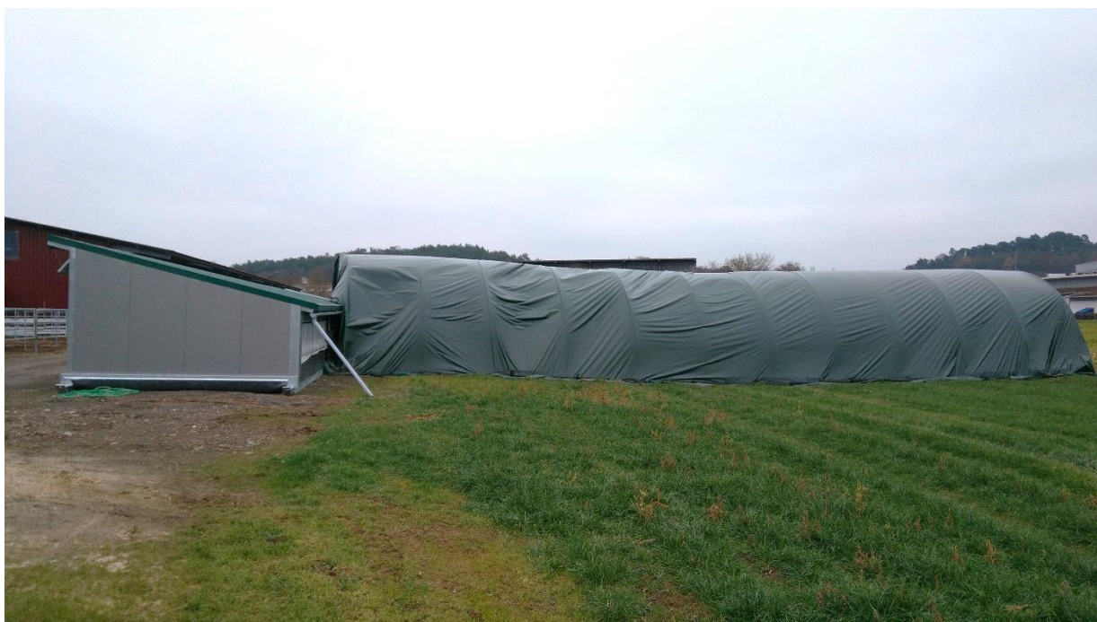
Abb. 2: Kleiner Mobilstall mit einer Erweiterung aus einem Folientunnelgestänge mit Abdeckvlies. Die Frontseite kann mit einem Netz oder Hasendraht verschlossen werden. Zur Versorgung sollte eine Tür eingebaut werden.
