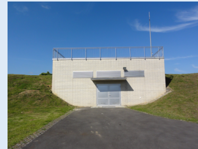
Abb. 4 Limburgs größter Hochbehälter fasst 6.000 m³ (Außenansicht)
