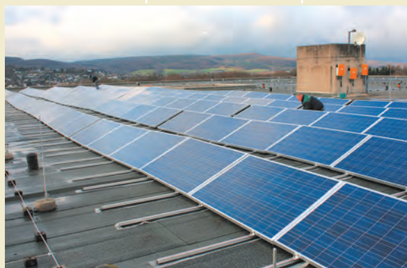
Installationsarbeiten für die Fotovoltaikanlage auf dem Dach der Heinrich-von-Gagern-Schule in Weilburg.
