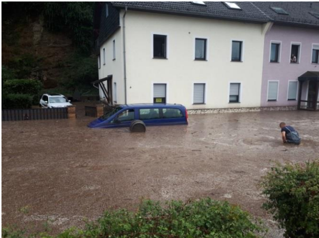
Abb.21: Überflutung in Aumenau nach Starkregen
