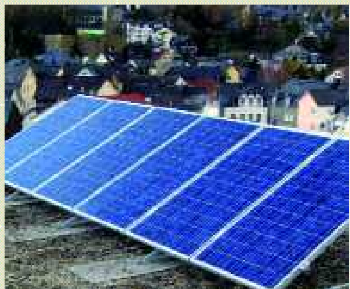
Flachdachmontage von Gecko Logic.
