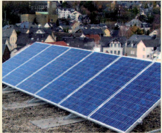
Flachdachmontage von Gecko Logic.
